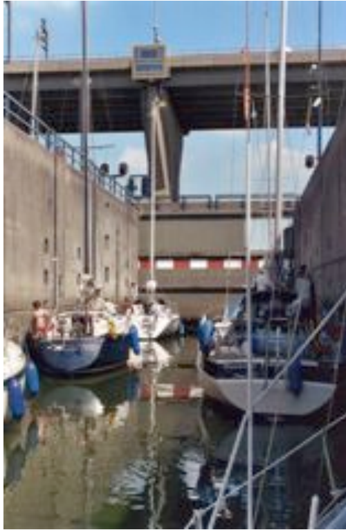
Volkeraksluizen : on voit distinctement les rangées de bollards
